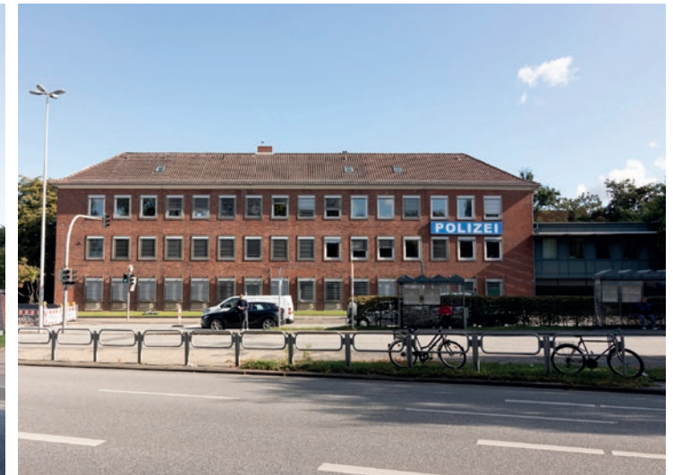
Abb. 6: Nordöstliche Bestandsbebauung Polizeirevier- Werftstraße 217 (Foto: KÜSSNER Verschattungsgutachten, Stand 22.09.2022)
