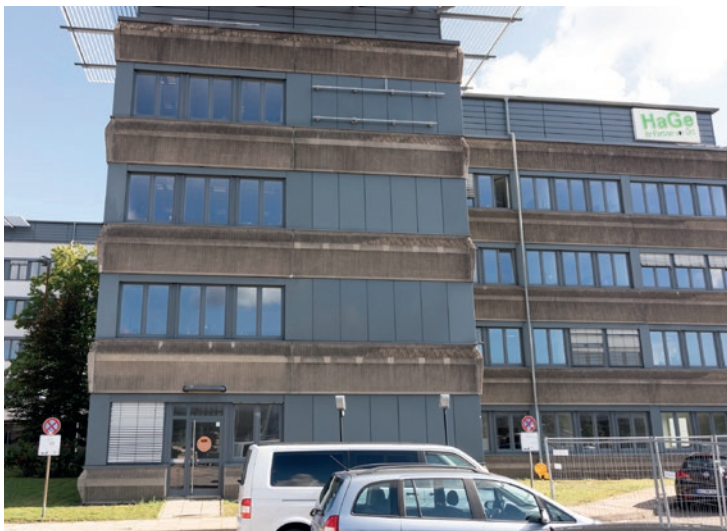
Abb. 7: Nördlich anschließende Bebauung der HaGe Nord - Werftstraße 218 (Foto: KÜSSNER Verschattungsgutachten, Stand 22.09.2022)
